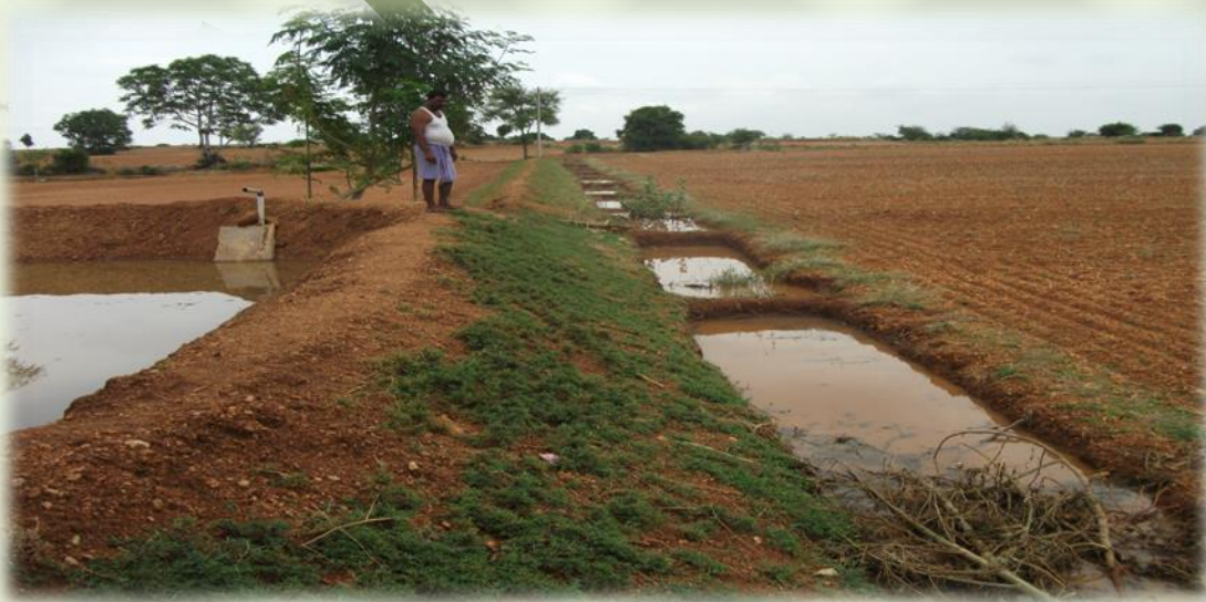
Trench cum bund
